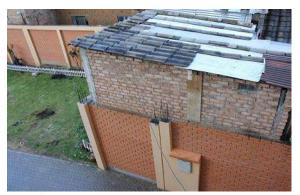
Se encontró los muros perimétricos, en algunas zonas faltan completar su altura requerida.
