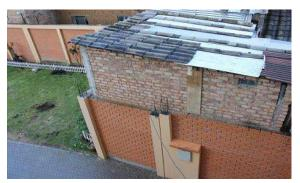
Se encontró los muros perimétricos, en algunas zonas faltan completar su altura requerida, con vista a casas aledañas.
