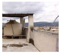
Se encontró 2 tanques de 2500 litros, al parecer sin mantenimiento desde su instalación, totalmente sucio en su interior, los filtros en mal estado. En la azotea se encontró arena suelta y cosas en desorden.
