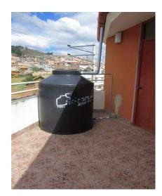
En la azotea se encontró un tanque a ras de piso con un filtro en mal estado y sucio en su interior, los servicios higiénicos desabastecidos de agua, no se tiene ventilación.
