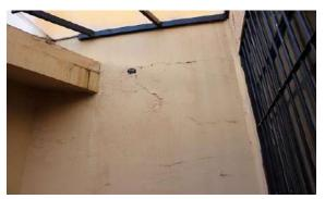
Techo, con bastante filtración de agua de lluvia e incluso ingresando al equipo acelerográfico, paredes con pintura deteriorada.
